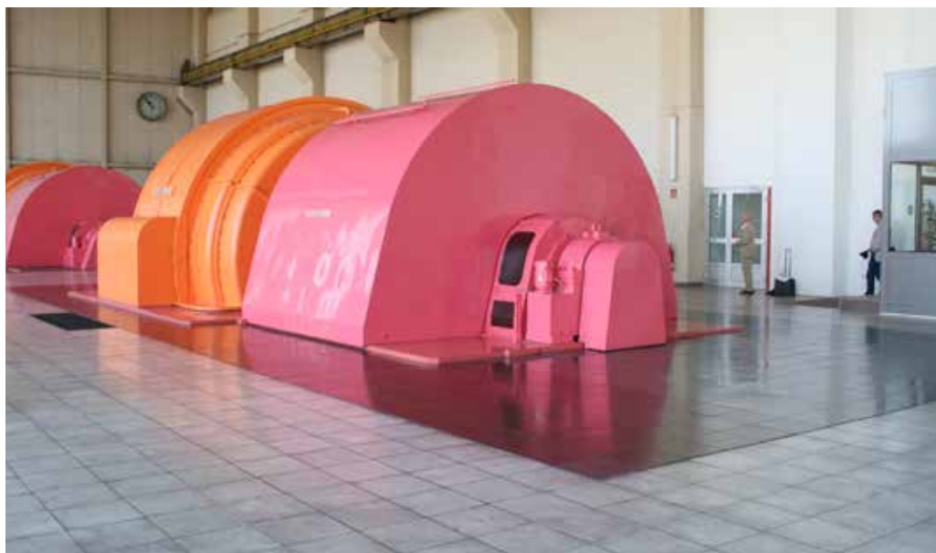
Im Bahnstromumformerwerk wird Drehstrom aus dem öffentlichen Netz in Bahnstrom der Frequenz 16,7 Hz umgewandelt: Maschine im Umformerwerk Karlsruhe. Links befindet sich der Motor, rechts der Generator. Die Leistung beträgt etwa 25 MW. Man beachte die Personen rechts als Größenvergleich. Foto: Fenchel
