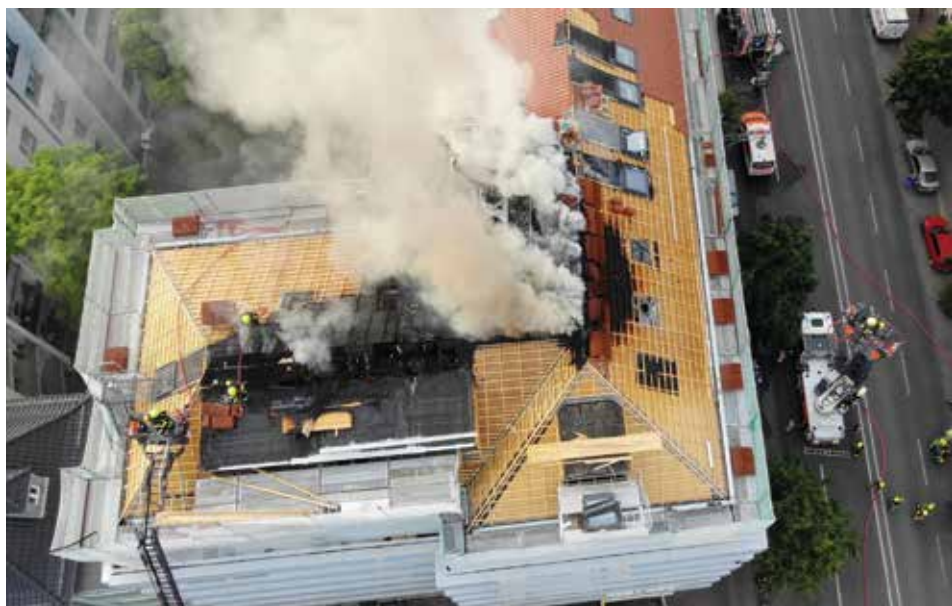
Bild 1: Dachstuhlbrand mit Beteiligung von Holzfaserdämmstoffen.
